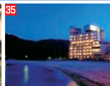
35 洲本温泉海月館本館 (旅館)
