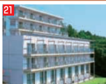
21 ホテルアンビエント伊豆高原 コンドミニアム
